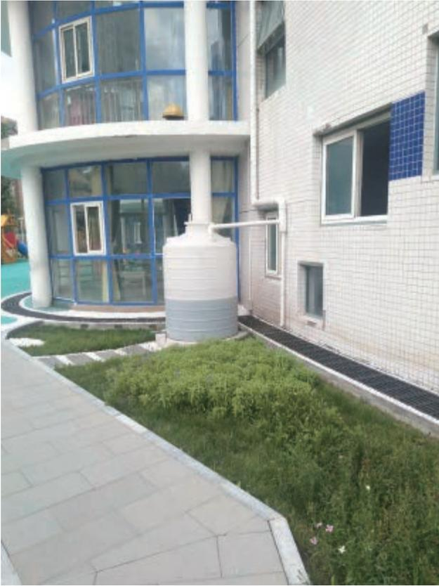
图19 海绵改造后效果展示1（下沉式绿地+雨水桶）
