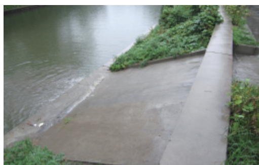
图7 长河雨水口改造前
