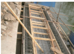
图13 长河雨水口改造施工中
