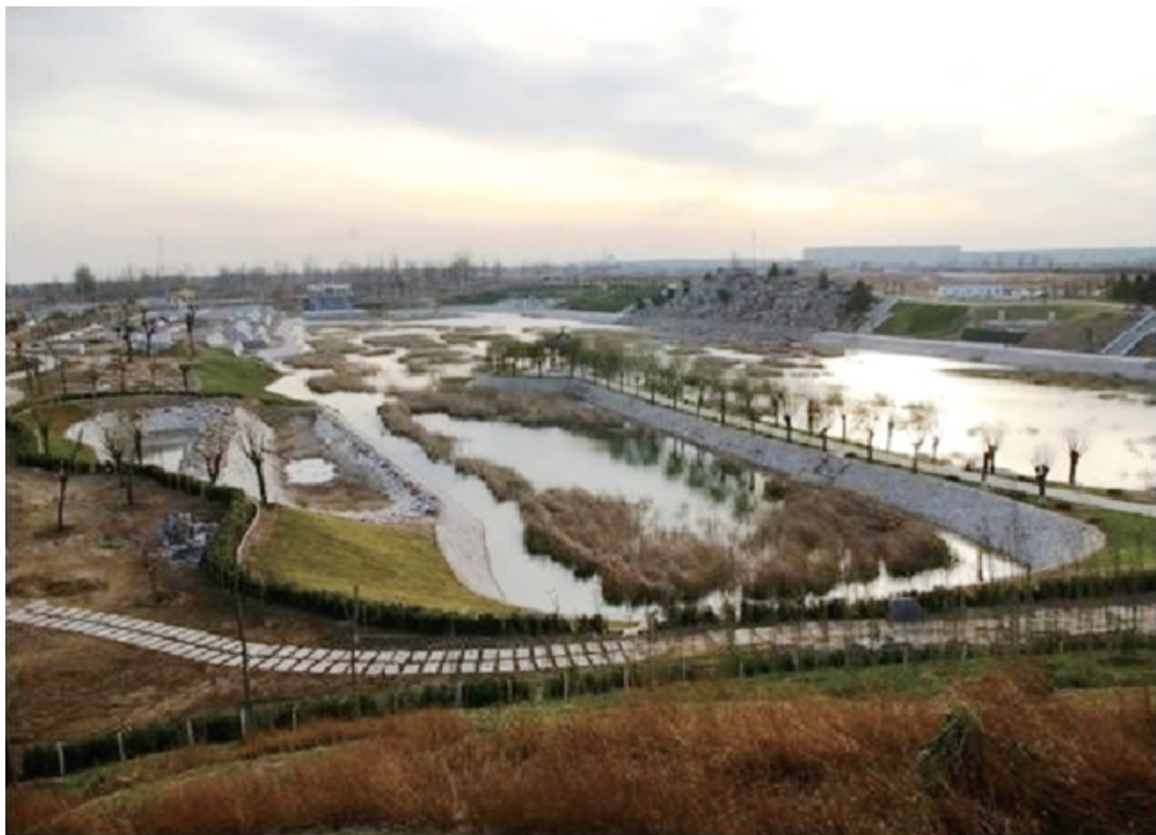
图2 多功能调蓄水体公园实景
