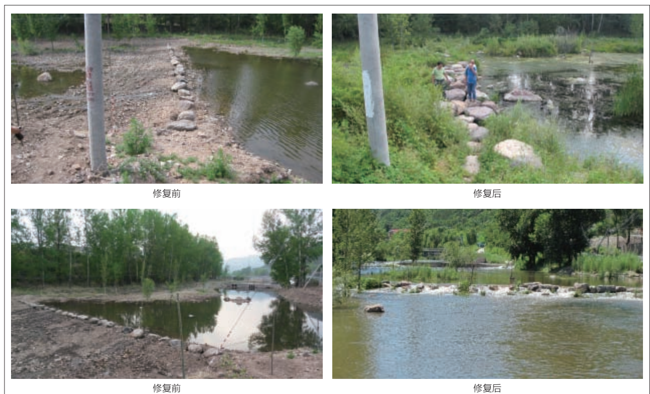
图8 散水坝改造、修复纵向连续性
