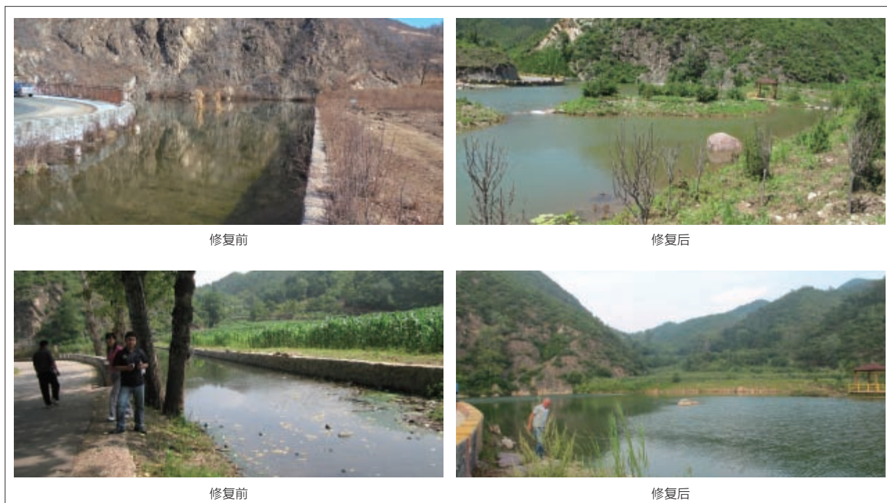
图5 浆砌石坝拆除、拓展防洪空间
