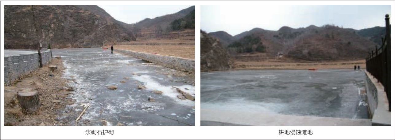
图3 下花楼塘坝现状
