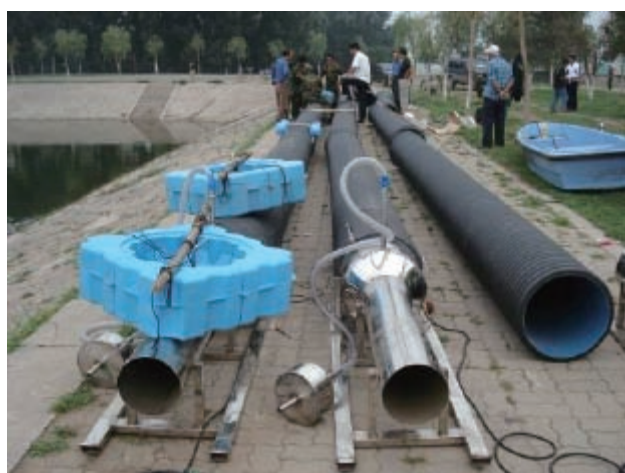
图21 在岸边组装推流曝气机
