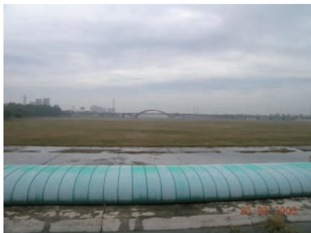
图3 “引温济潮”工程来水前潮白河河道状况
