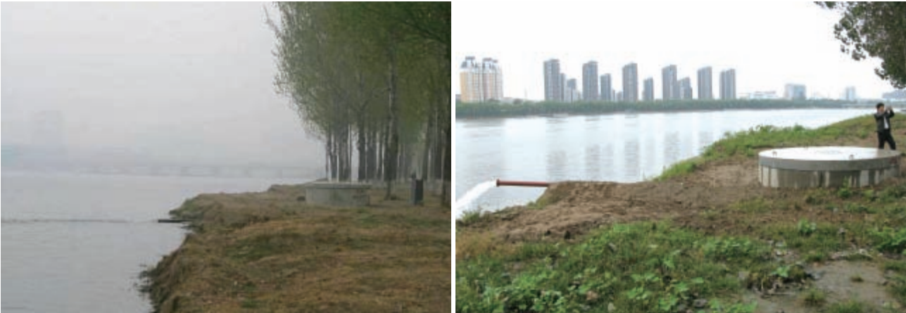
图17 建成后运行中的辐射井
