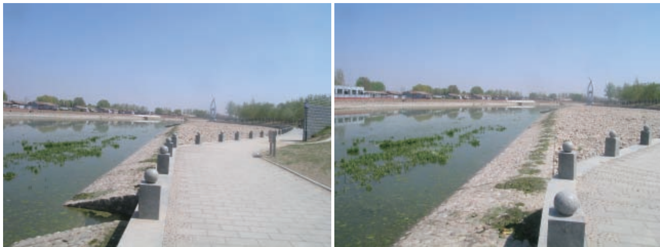
图9 2007年城北减河双兴桥段（南向）
